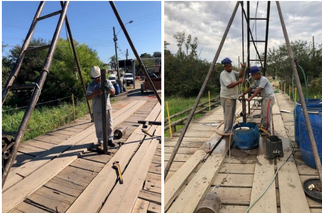
Imagem 3 – Execução do ensaio SPT
