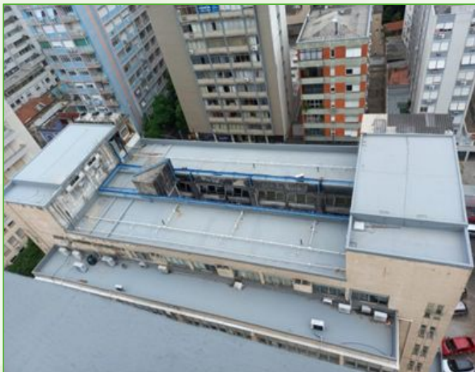
Impermeabilização da cobertura do HMIPV
