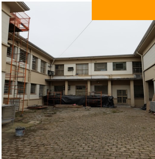
CS Navegantes - Em execução
