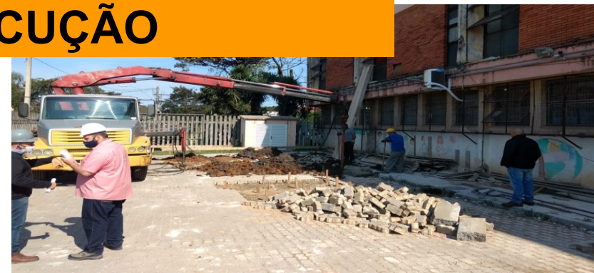
US Vila Cruzeiro (FASE) - Em execução
