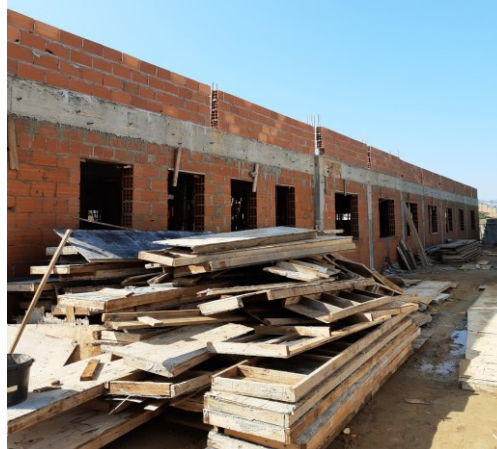
US Mato Sampaio - Em execução
