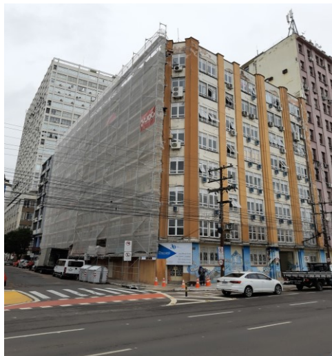
CS Santa Marta - Em execução
