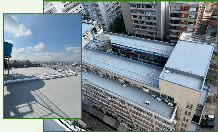
Impermeabilização da cobertura do HMIPV
