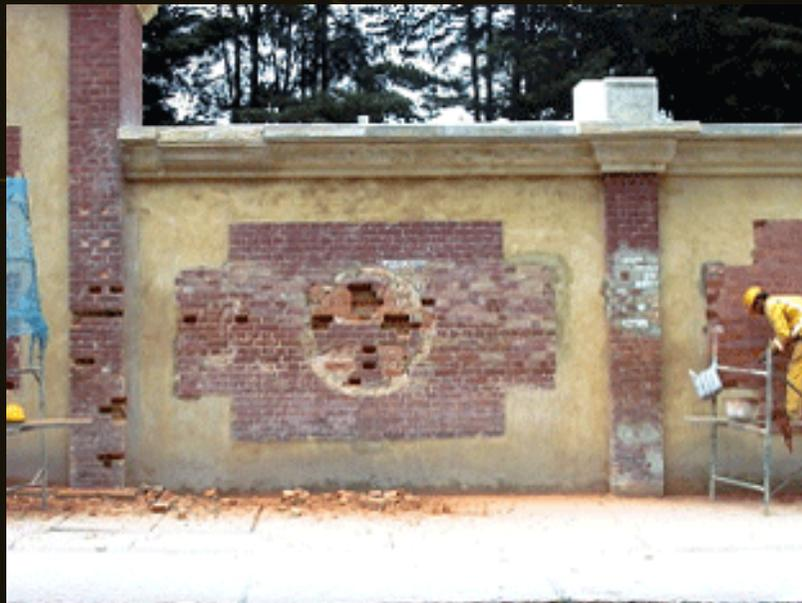
Proceso de desmonte de piezas de ladrillo erosionadas
