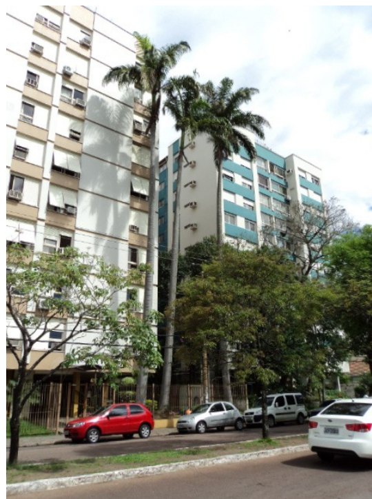
Palmeiras Av. Venâncio Aires, 611 – Bairro Originalmente em nº de quatro vegetais. Atualmente existem três, sendo que a do meio apresenta necrose grave na base do vegetal. Revisada– Dec.18.148/03.01.2013 Exclusão da Nº 2.
